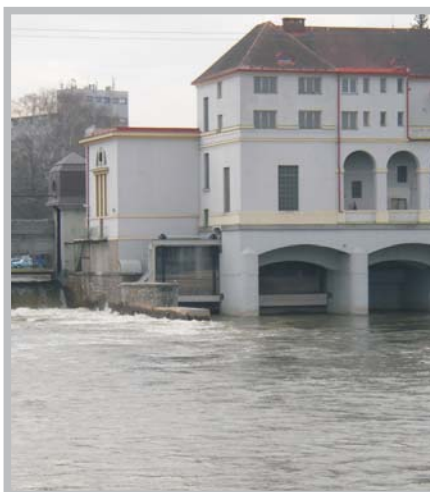
Stavidla výtoku z turbín VE Přelouč - 2004 ČESKÁ REPUBLIKA
